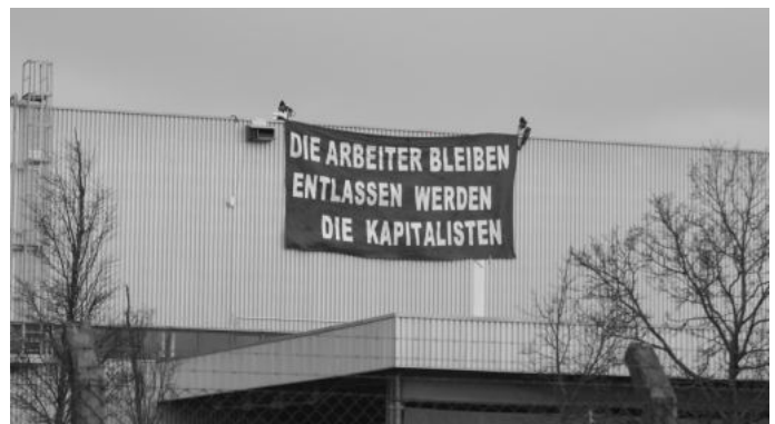
BMW-Werk Regensburg, Montagehalle 55 15.3.2021
